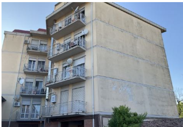
foto 1 – immobile – prospetto sud-est
