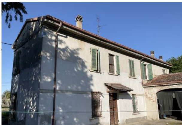
foto 1 – immobile – prospetto sud-ovest
