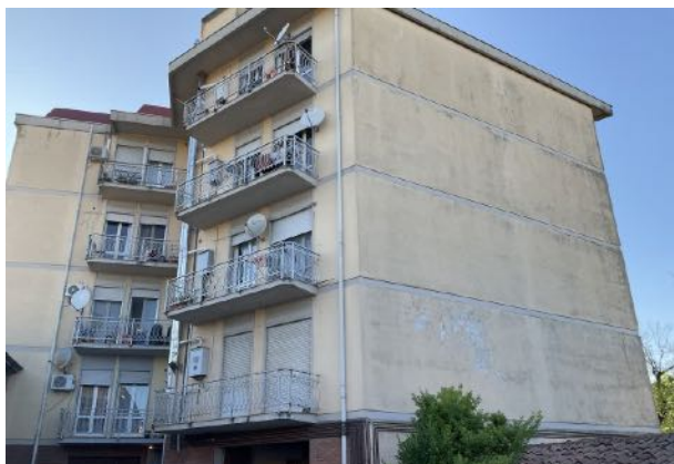
foto 1 – immobile – prospetto sud-est
