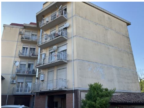
foto 1 – immobile – prospetto sud-est
